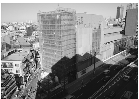
上條記念館建設現場（1月撮影）
