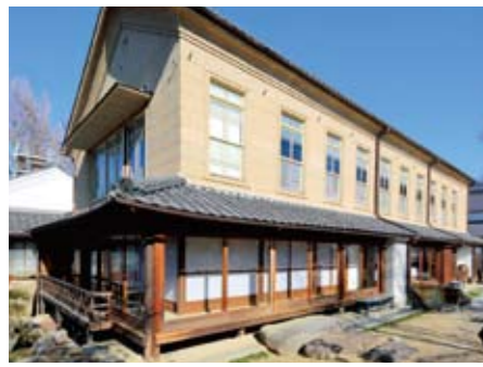
宮光園の主屋。2階は養蚕の部屋だったのを洋風に改装し、屋根も高直した。
