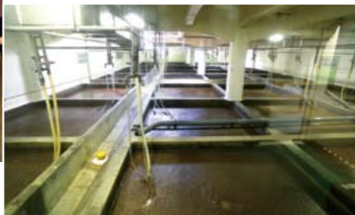
「もろみ」を熟成するコンクリートタンク。現在ほとんどが屋外大型タンクでの仕込だが、昭和5年の工場には一部昔ながらの設備も残る。(ヒゲタ醤油・見学コース外)
