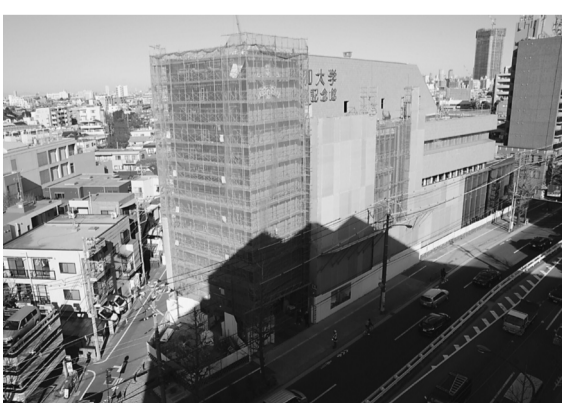
上條記念館建設現場 (1月撮影)
