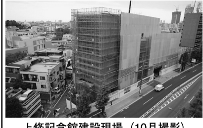
上條記念館建設現場（10月撮影）
