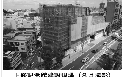
上條記念館建設現場（8月撮影）
