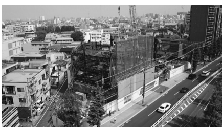
建設現場(5月撮影)
