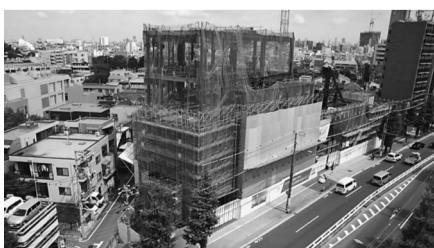
建設現場(7月撮影)
