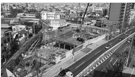
建設現場(3月撮影)
