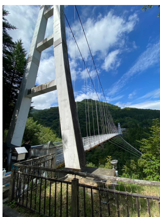
写真1 スカイブリッジ
