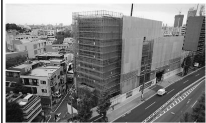
上條記念館建設現場 (10月撮影)
