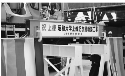
金と銀のボルトが締められた最後の鉄骨
