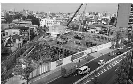
建設現場（東病院から11月初旬撮影）
