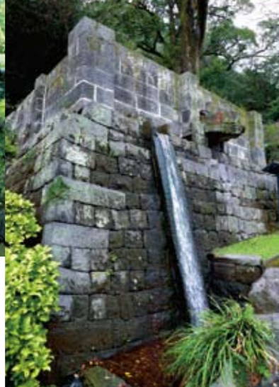
水力発電用ダム跡。明治中ごろにつくられ、水の落差で発電し、御殿の電力をまかっていた。
