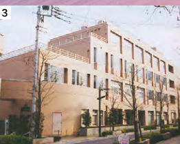
竣工直後の新校舎
