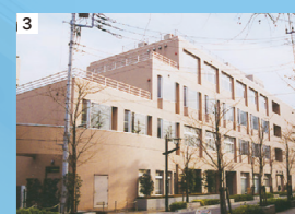
竣工直後の新校舎
